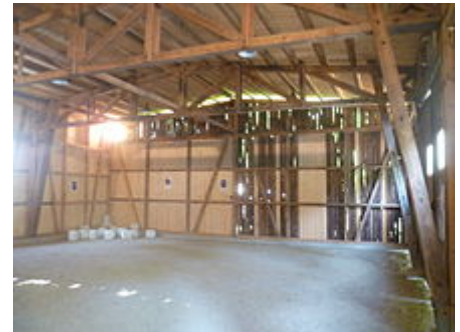
Innenansicht der Busgarage
